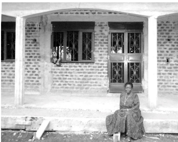
Het nieuwe gebouw is bijna klaar ...
